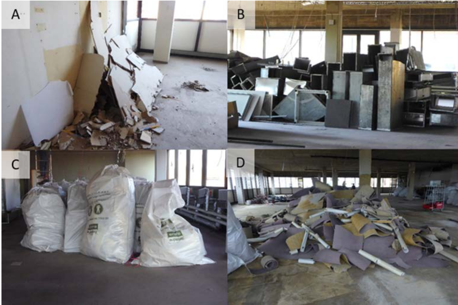
Beispiele für separat gelagerte Fraktionen aus dem Schadstoffausbau und die Entkernung (A) Rigips Platten (B) Metall (Lüftung) (C) KMF-Dämmmaterial (D) gemischte Bauabfälle
